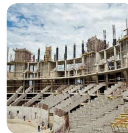
Сочи-2014: стройка века
